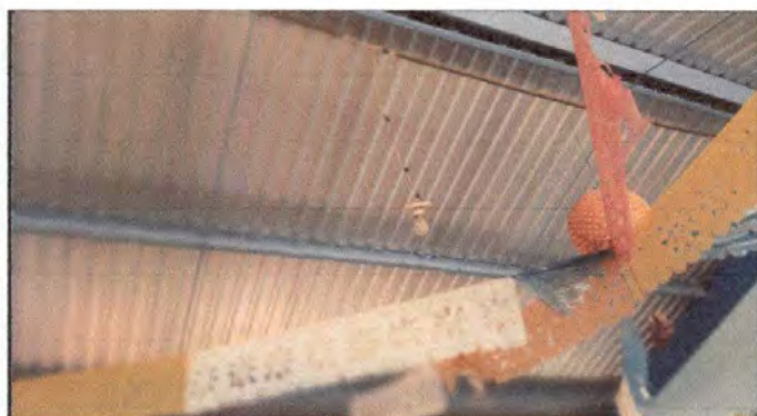
Foto 3. Sustitución de plafoneras (MODULO 1)
