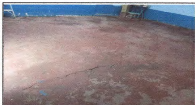
Foto 3. Sustitución de piso de torta de concreto por piso de granito (MODULO 1)
