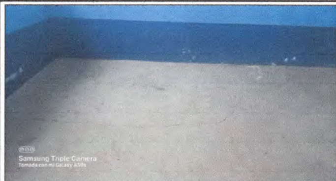
Foto 1. Sustitución de piso de torta de concreto por piso de granito (MODULO 1)
