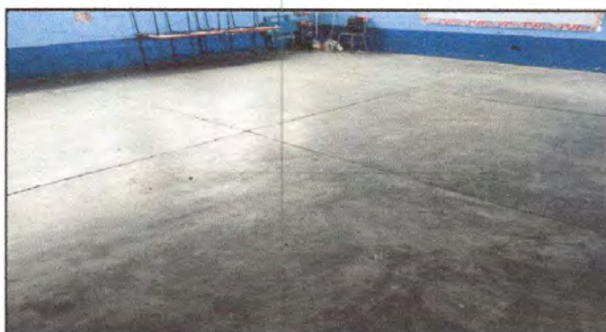
Foto 4. Sustitución de piso de torta de concreto por piso de granito (MODULO 1)
