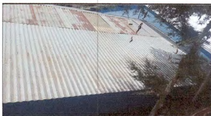
Foto 4. Sustitución de lámina, por lámina troquelada aluzinc calibre 26 (MODULO 1)
