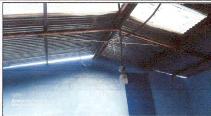
Foto 1. Reparación de cableado eléctrico (MODULO 1)
