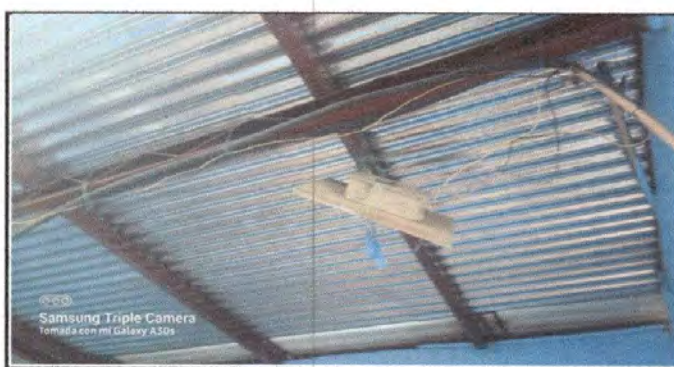
Foto 6. Sustitución de tablero de filipones (MODULO 1)
