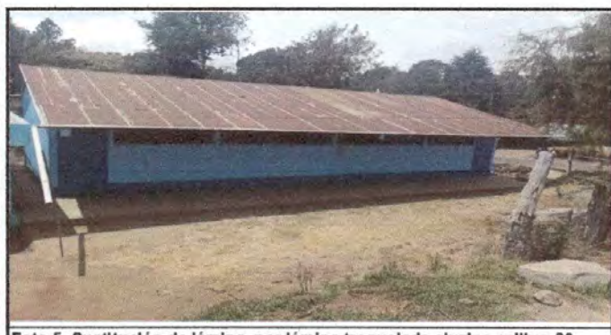
Foto 5. Sustitución de lámina, por lámina troquelada aluzinc calibre 26 (MODULO 2)
