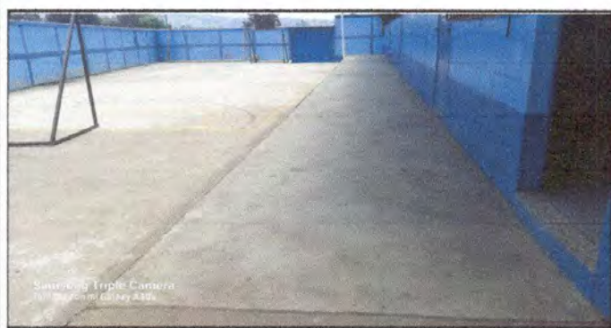
Foto 5. Sustitución de piso de torta de concreto por piso de granito (MODULO 1)
