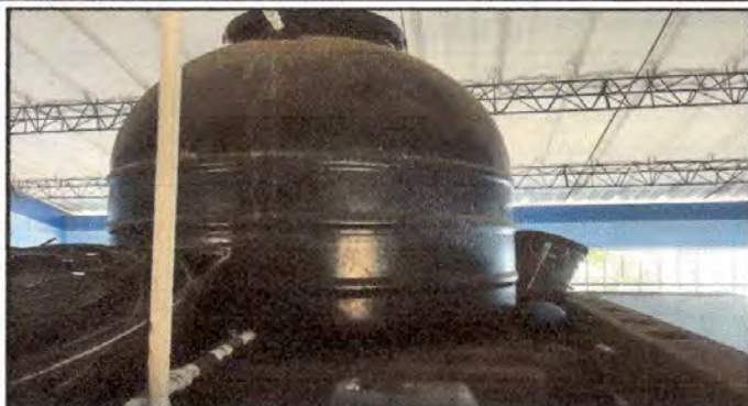
Foto 1. Sustitución de depósito de agua 1700 lt (MODULO 2)
