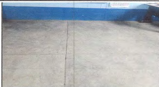
Foto 2. Sustitución de piso de torta de concreto por piso de granito (MODULO 1)
